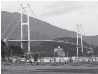
写真13. 美しい安芸灘大橋の全景 筆者撮影
